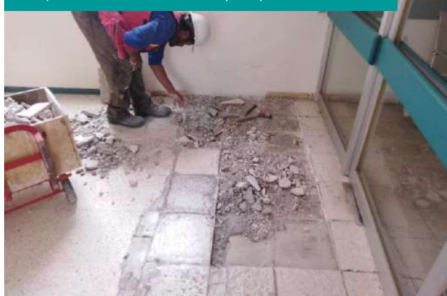
Hospital General de Chalco (Foto)
