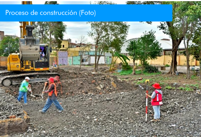
Proceso de Construcción (Foto)
