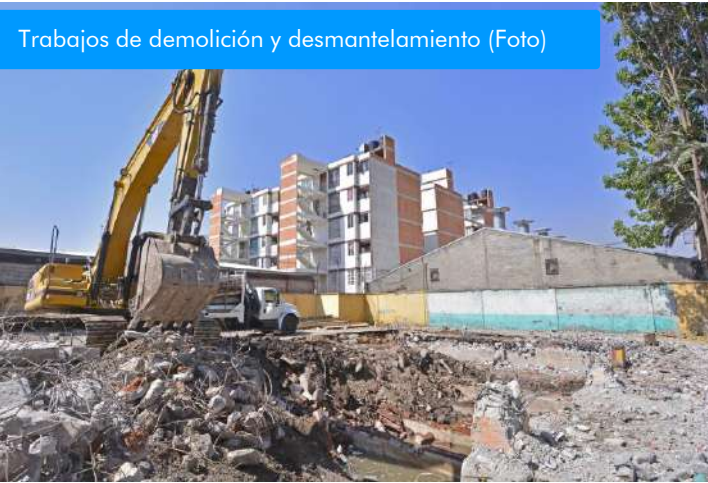
Trabajos de demolición y desmantelamiento (Foto)
