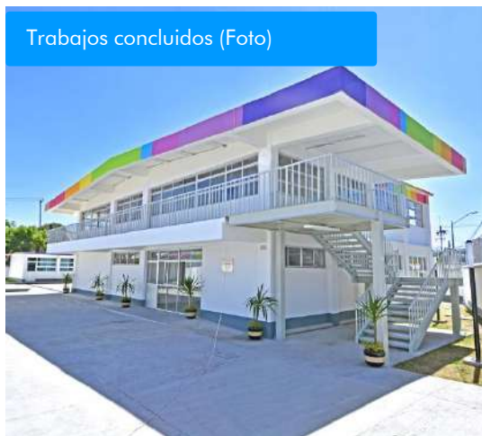
Trabajos concluidos (Foto)
