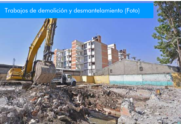
Trabajos de demolición y desmantelamiento (Foto)
