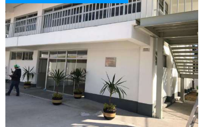
Trabajos concluidos (Foto)
