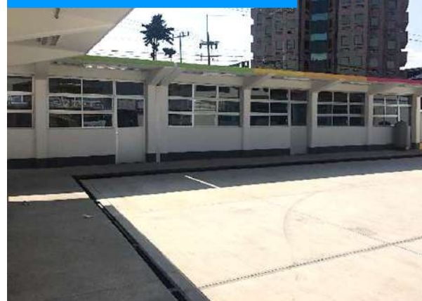
Trabajos concluidos (Foto)
