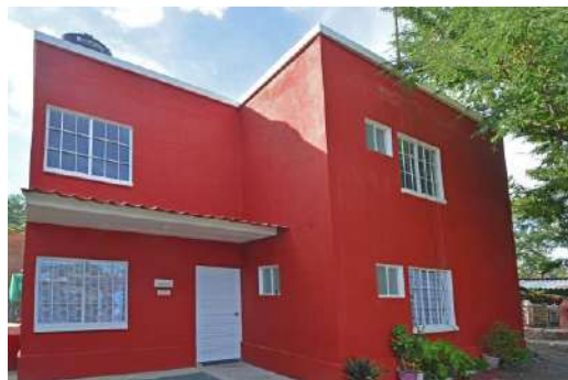
Vivienda terminada, Tepalcingo Morelos
