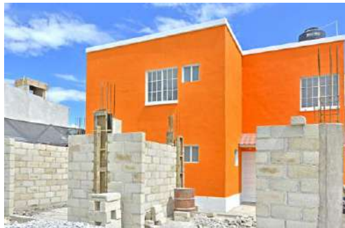
Vivienda terminada y en construcción, Jojutla Morelos
