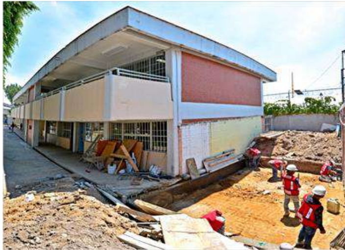
Prisciliano Martínez, Iztapalapa Trabajos en escaleras de emergencia (Foto)
