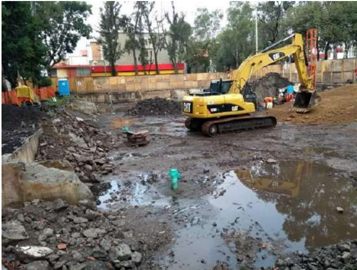
Demolición de losa tapa y contra trabes (Foto)
