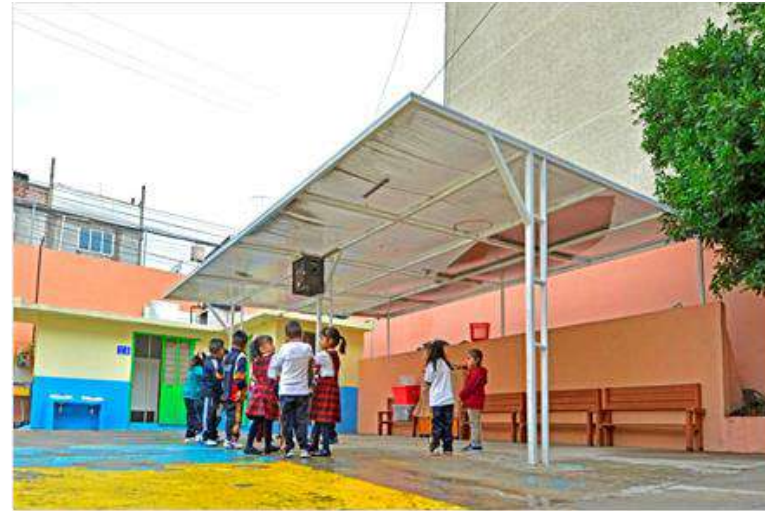
Preescolar "Tatokke", Tláhuac Colocación de piernas de tejado en instalaciones entregadas (Foto)
