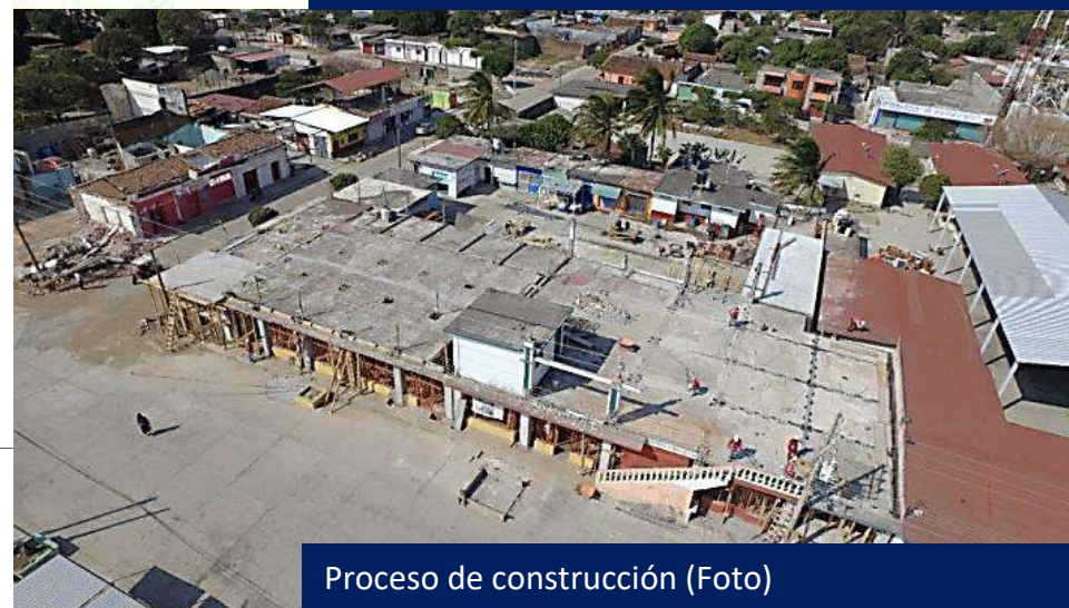
Proceso de construcción (Foto)
