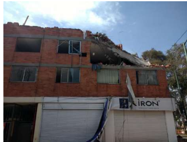
Edificio Calzada del Hueso 713, Tlalpan Daños por sismo – proceso demolición (Foto)
