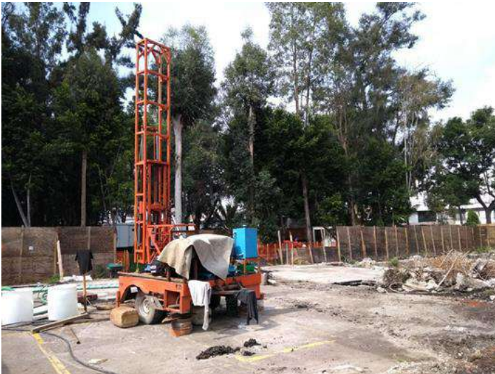
Habilitado de sistema de bombeo para construcción de pozos (Foto)
