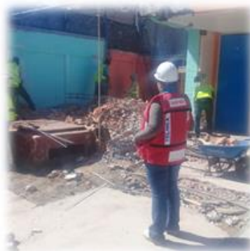
Reparaciones Primaria "Sostenes Nicolas Chapa Nieto", Tlahuac
