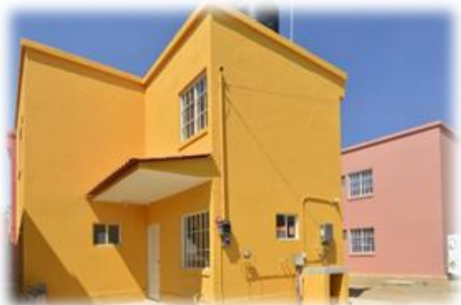
Vivienda terminada San Gregorio
