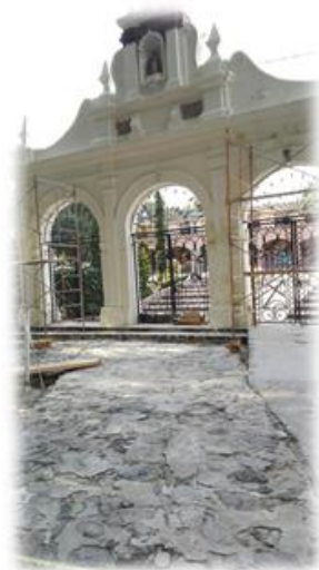
Reparaciones en Catedral de Teotihuacán
