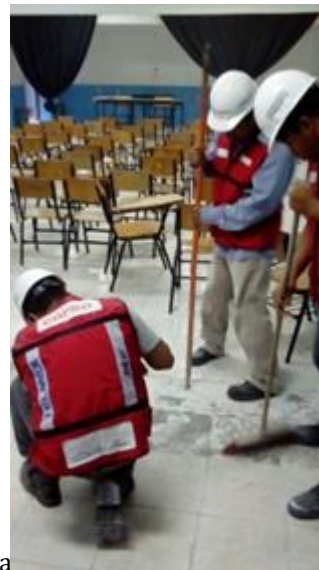
Reparaciones en el plantel República de Libano, CDMX
