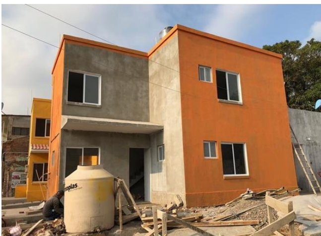
Proceso de construcción de vivienda, Juchitán
