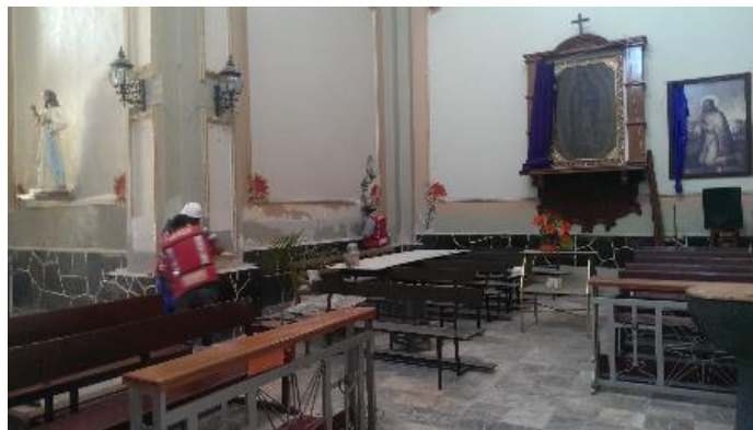
Reparaciones en la Iglesia de San Mateo Ahuitzingo
