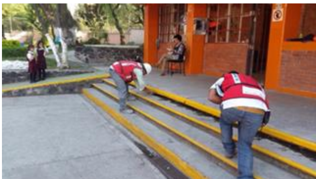
Reparaciones en el plantel Fuerzas Armadas de México, CDMX
